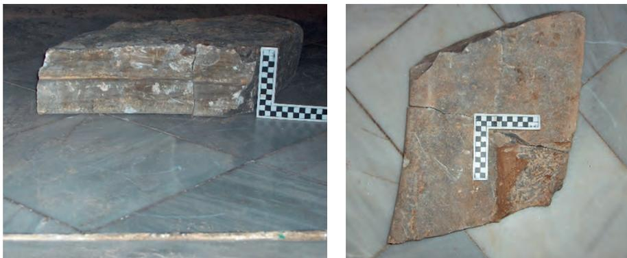
Fig. 12. Fragmentos de las piezas del antiguo umbral de la puerta principal de la iglesia. A la izquierda, detalle de la moldura situada en el extremo anterior de cada pieza; a la derecha, huella del encaje de un quicio conservado en una de ellas.
