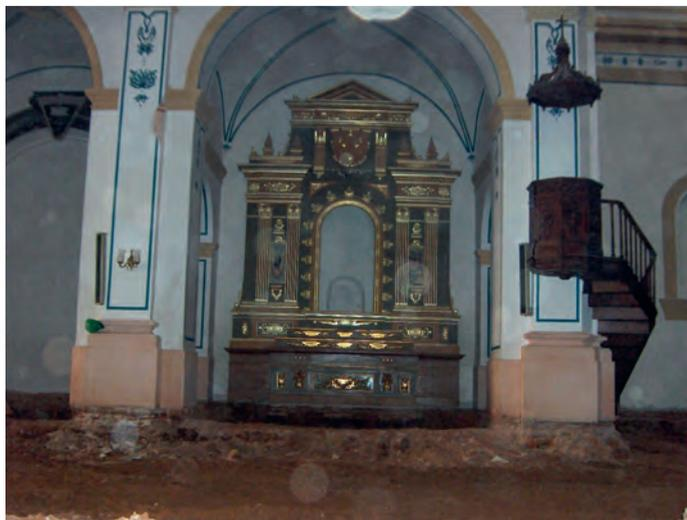
Fig. 9. Cabecera de la iglesia. Vistas de una de las capillas laterales en la nave lateral occidental. Se aprecian los tirantes de cimentación que unen ambos pilares una vez retirado el pavimento.
