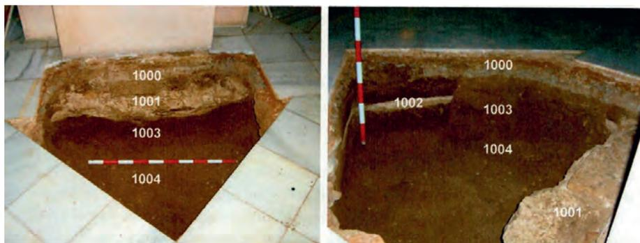
Fig. 7. Vistas de la Cata 1, donde se aprecia la cimentación del pilar sobre niveles estériles.
