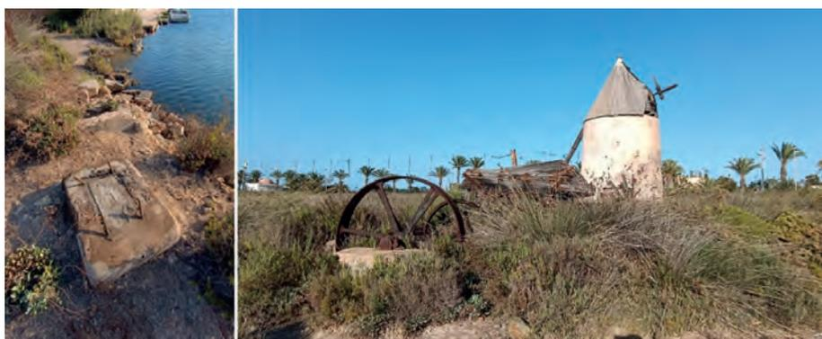
Figuras 15 (izqda.): Detalle de los restos del edificio destruido, donde se hallaba el motor. Figuras 16 (dcha.): Conjunto del sistema de poleas y ruedas dentadas que accionaban el tímpano en la instalación aneja al molino BIC nº167 y al fondo el molino con los restos muy deteriorados del suyo. Fuente: El autor.
